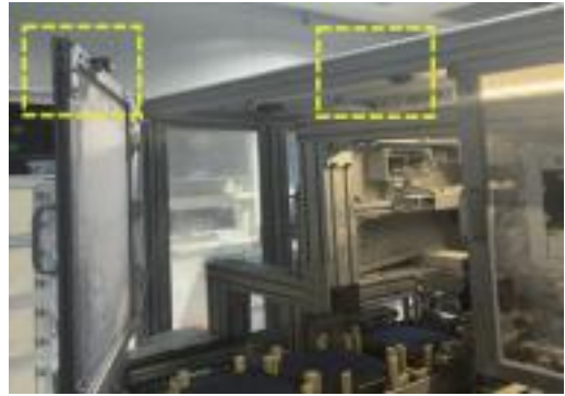
개선 후 (인터락 설치)
